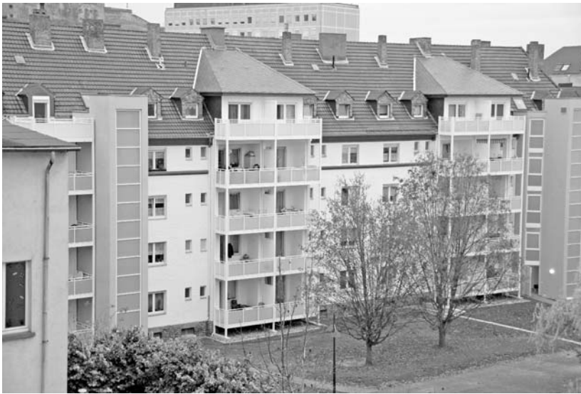
Wohnwertsteigerung durch den nachträglichen Anbau von Aufzug und Balkonen einer Wohnanlage in der Hohenzollernstraße.
