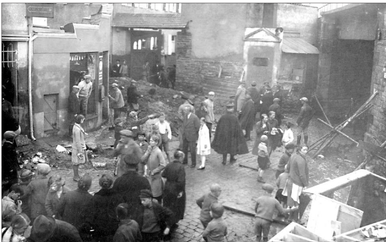
Anwohner und Schaulustige bestaunen die verheerenden Auswirkungen des Wolkenbruchs in der Teichstraße.
