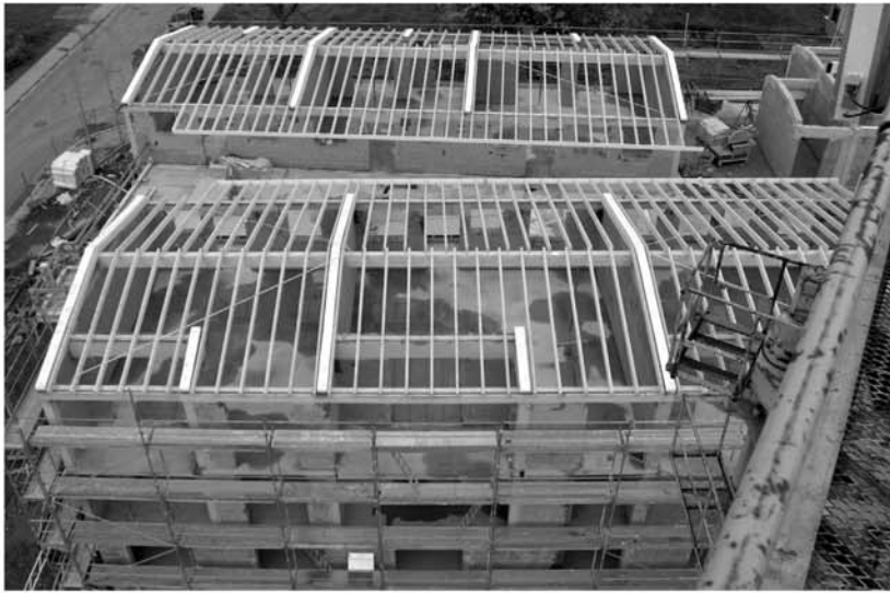
Blick auf die Laubenhof-Baustelle wenige Tage vor dem Richtfest.
