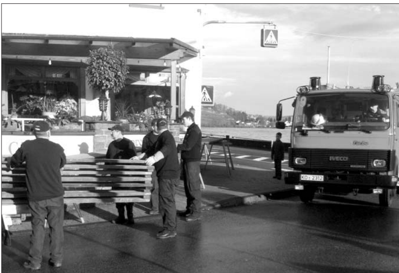
Vorbauende Maßnahme: Aufbau der Stege vor dem Hotel Kreuter an der Ecke Stauseestraße.
