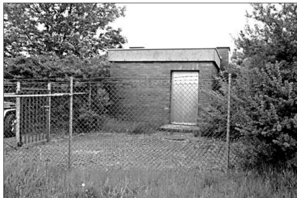
Bisholder Wasserwerke: Hochbehälter auf dem Berg . . .
