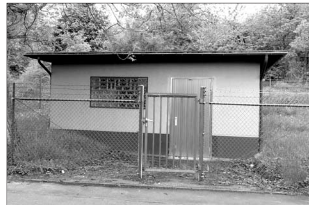
. . . und die Pumpstation im Bisholderweg.
